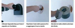
Utilizzare l'apposita fresa per trare il cappotto con l'eventuale Riavviare il resto dello spessore fino a raggiungere il muro di sotto Stendere la malta coltata sulla base del cilindro
